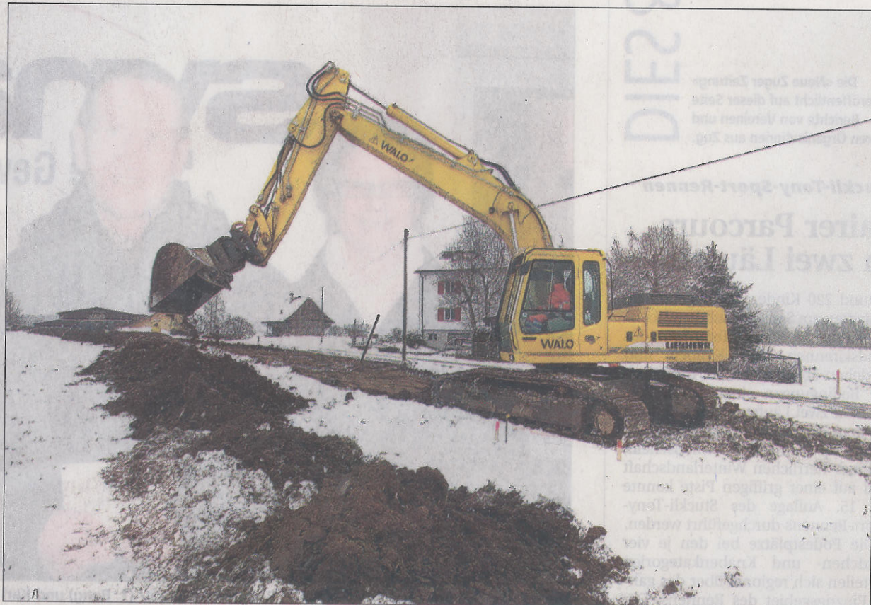
Seit Montag wird nun in der Fildern die Erschliessungsstrasse gebaut.
